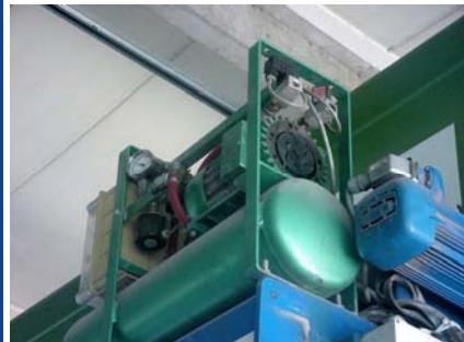
Вакуумный насос 7002-COMP на подкрановом пути
